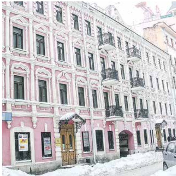
Четырехэтажный дом 1866 года, архитектор Н. Карнеев
