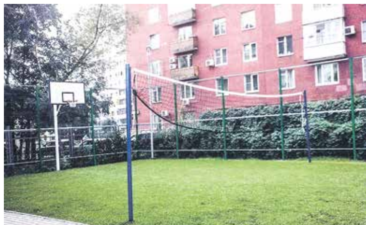
Капитальный ремонт спортивной площадки по адресу: Плетешковский пер., д. 3А. Здесь все приспособлено для людей с ограничениями по здоровью.
